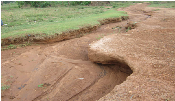
Photo 4 : Erosion par la méandre de l'eau de rucèlement
